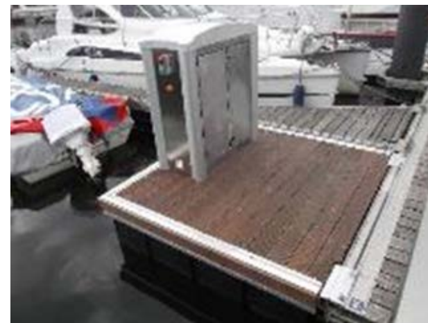
Exemple de pompe d'aspiration (sans habillage).
